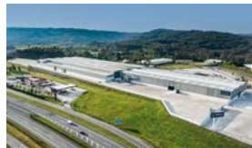
4 CORTIZO COIRÓS CENTRO DE RECICLAJE RECYCLING CENTRE
