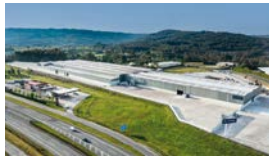
4 CORTIZO COIRÓS CENTRO DE RECICLAJE RECYCLING CENTRE
