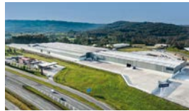
4 CORTIZO COIRÓS CENTRO DE RECICLAJE RECYCLING CENTRE
